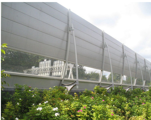
Figure 67 : Écran antibruit à surface courbe et ajourée d'une section en verre. Photo : © GFDL, 2012
