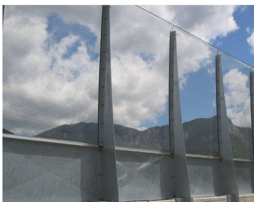
Figure 74 : Écran antibruit composé de métal avec vitrage. Photo : © Austrian Academy of Sciences - Acoustics Research Institute, 2012
