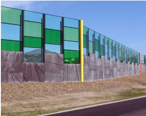
Figure 75. Écran antibruit composé en blocs de béton brun texturés et vitrage coloré vert avec poteaux colorés. © Ausplastics Pty Ltd, 2012
