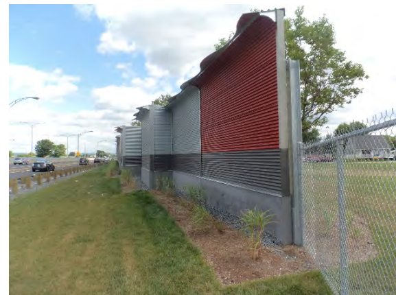
Vue du côté de la route.
