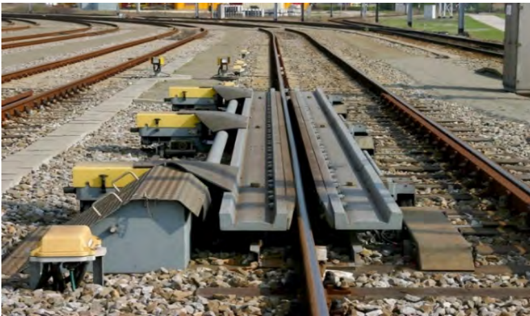
Photo 21 Freins de voie dans une gare de triage
