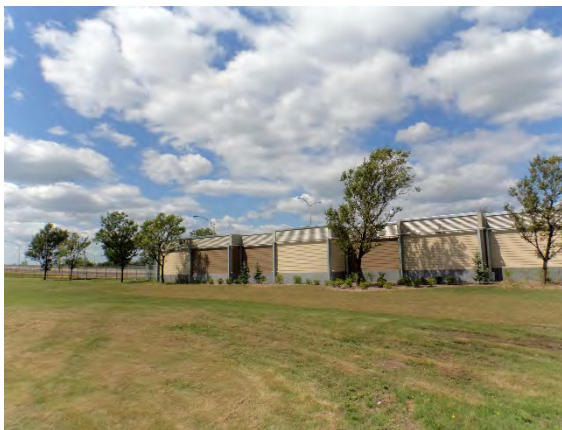
Vue du côté des résidences.
