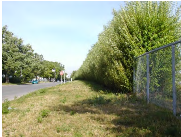
Mur-écran végétalisé installé le long d'une partie de l'autoroute 15, à Laval, le long de la rue Guillemette. Le mur est principalement constitué de terre retenue par une membrane géotextile qui s'insère dans une structure de bois. L'ensemble du mur est entouré de végétation (saule).
