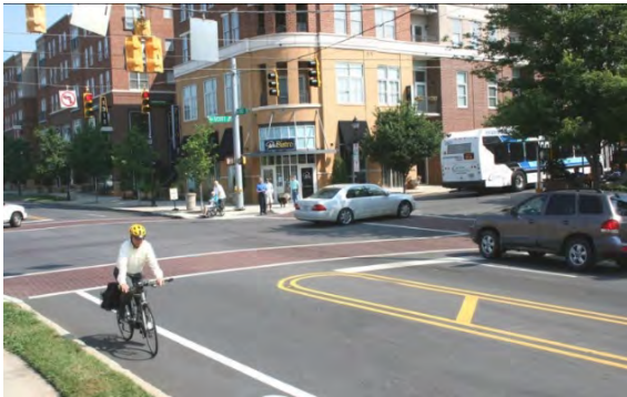
Intersection d'un centre-ville avec traverses piétonnières visibles, ajout d'arbres, et un bon marquage de la chaussée. Ville de Charlotte, Mecklenburg County (NC). Crédit photo : City of Charlotte, Department of Transportation).
