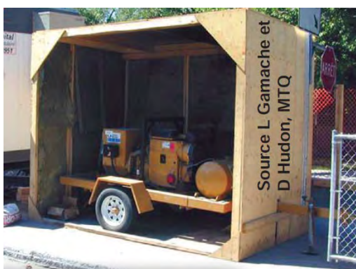
Photo 25 Écrans antibruit temporaires pour des chantiers de construction
