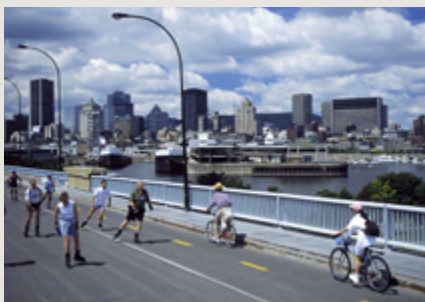
Piste cyclable sur le pont de la Concorde
