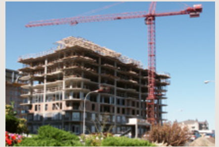
Immeuble résidentiel en construction
