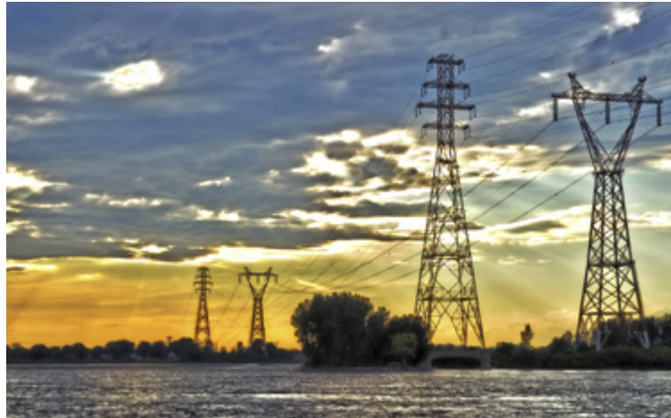
Lignes aériennes de transport d'énergie électrique
