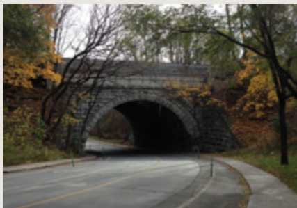
Le viaduc du chemin Glen, à Westmount
