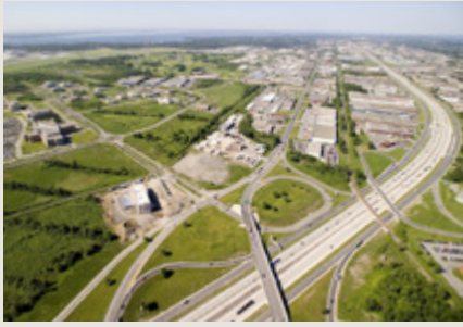
Vue aérienne de l'Éco-campus Hubert Reeves et du réseau routier environnant
